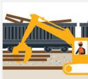
Les coupons de rail et les traverses usagés sont retirés de la voie ; l'engin de maintenance attrape l'appareil de voie en une ou plusieurs parties et les charge dans un wagon.
