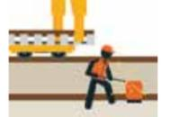
L'engin repose l'appareil de voie au millimètre près. Les soudures sont réalisées et une bourreuse mécanique lourde vient tasser le ballast et le niveler.
