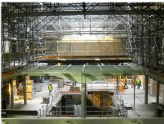
Les niveaux se construisent
