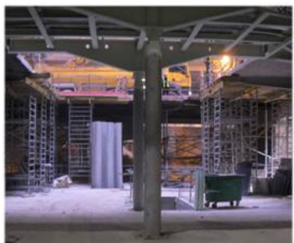
Des piliers tous les 10 mètres permettent de soutenir les structures
